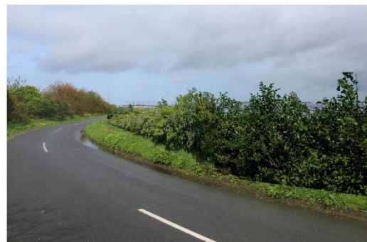
Smerpølvvej 20A 7650 Bøvlingbjerg Fotovinkel 5 før- og efter, med og uden beplantning
