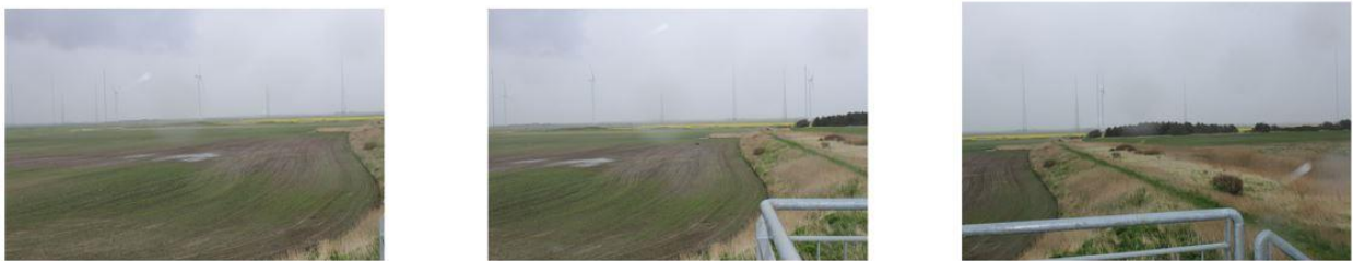
Figur 4.3 FØR – fra taget af pumpehus på Torsmindevej. Disse billeder smeltes sammen til et billede.
