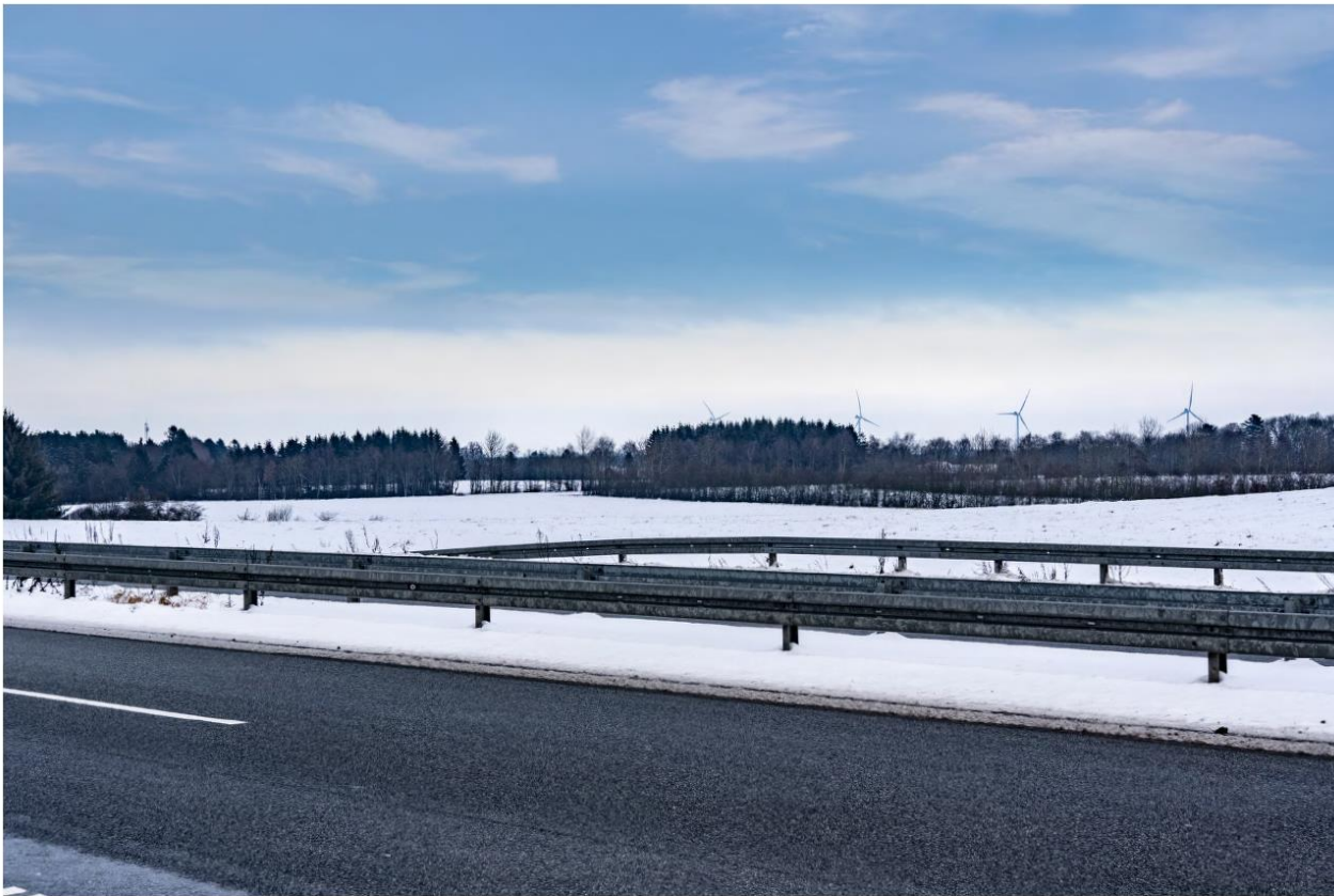
5: Fra motorvejen nær afkørsel 20 Eksisterende forhuld, 50 mm
